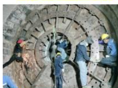
งานเชื่อมโครงสร้างตะแกรงท่าย Z2
