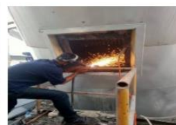
งานเชื่อมฝา manhole ลมร้อน
